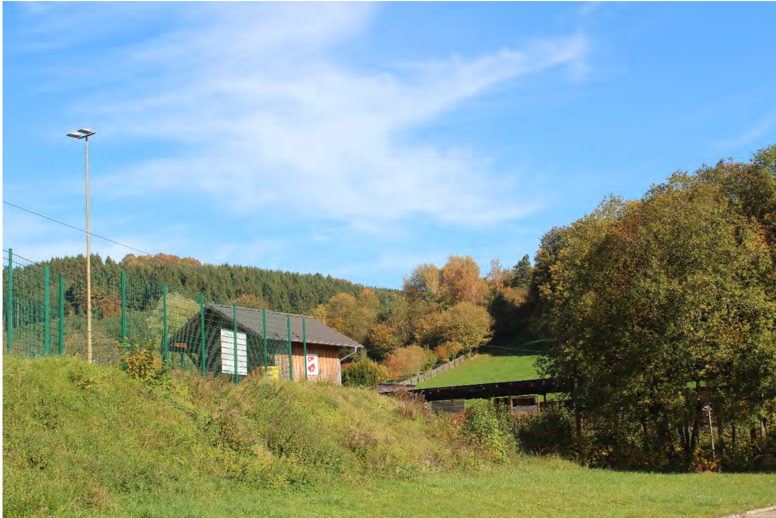
Abbildung 12a: Foto vom Parkplatz des Giebelscheider Sportplatzes (Betrachtungspunkt 12) in nordöstliche Richtung
